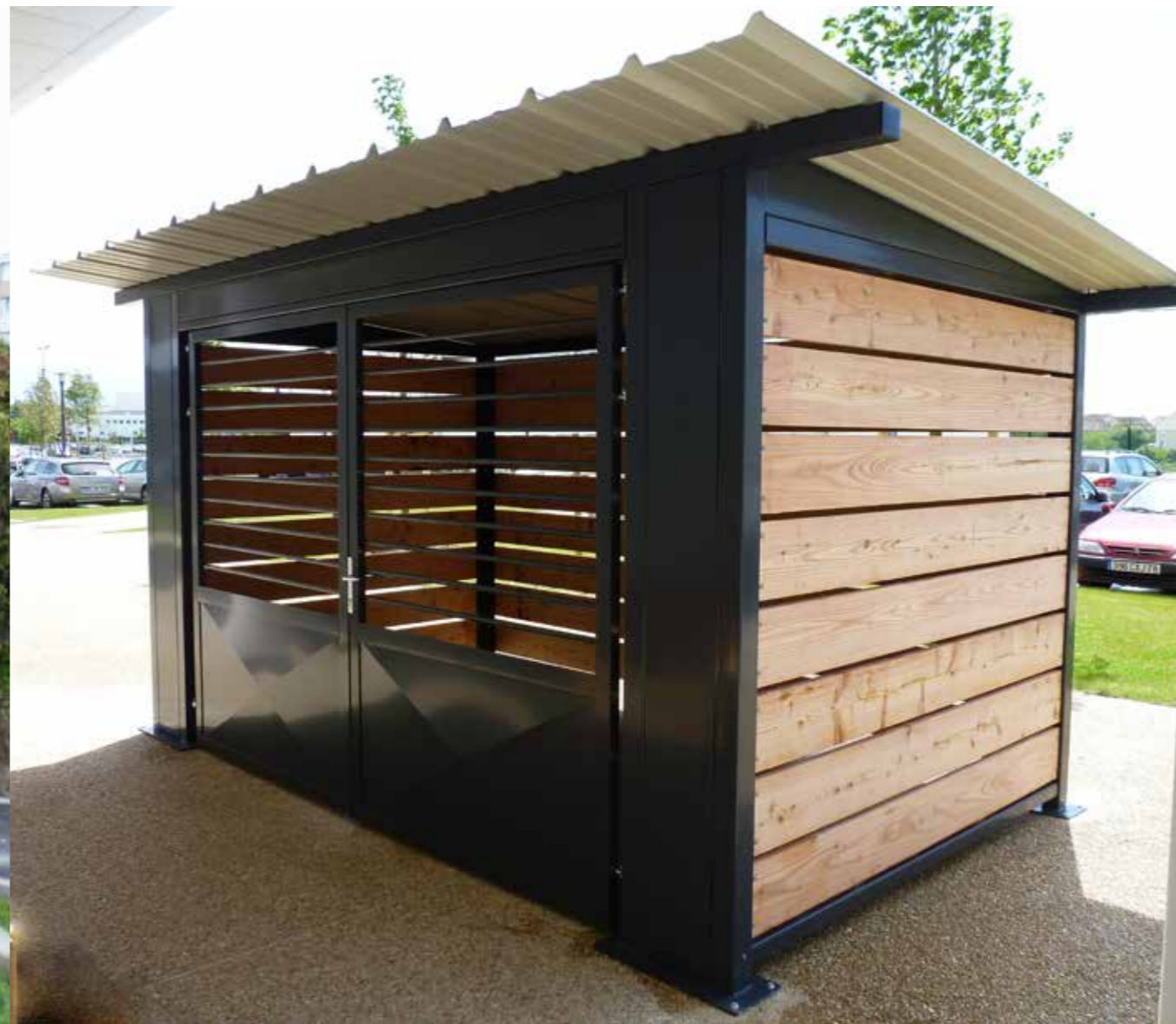
Les Mureaux - EADS Abri spécifique fermé, bardage bois.
